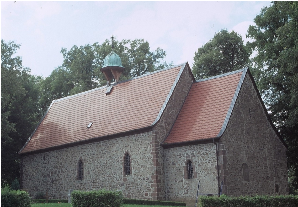
Abb. 1: Ansicht der Kapelle von Südosten (Aufnahme K. Thiersch)
